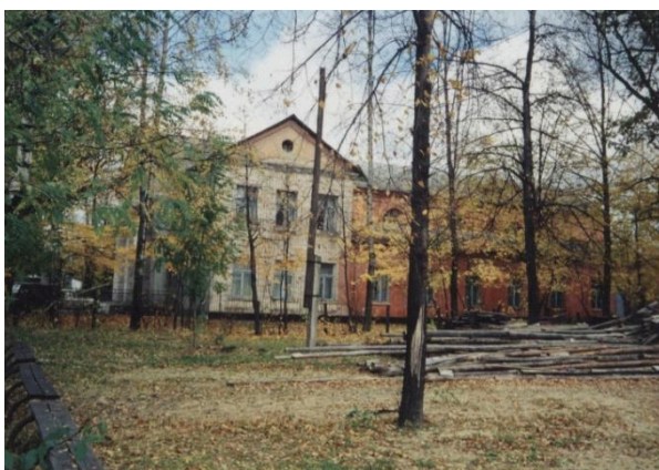
Fot. 8. Kościół w Rokitnie w trakcie remontu (1998 r.), po wojnie utworzono z niego dom kultury
